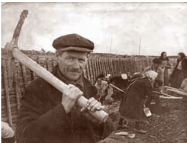
На земляных работах
